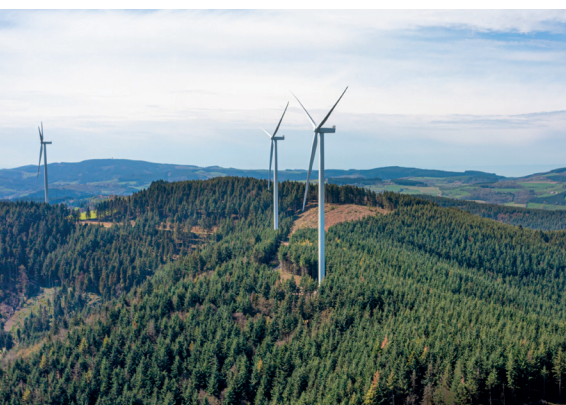
Parc éolien du Beaujolais Vert (Auvergne-Rhône-Alpes) – 12 MW : premier parc éolien du Rhône, développé en étroite collaboration avec le territoire, il s'inscrit dans la démarche locale de Territoire à Énergie Positive.
