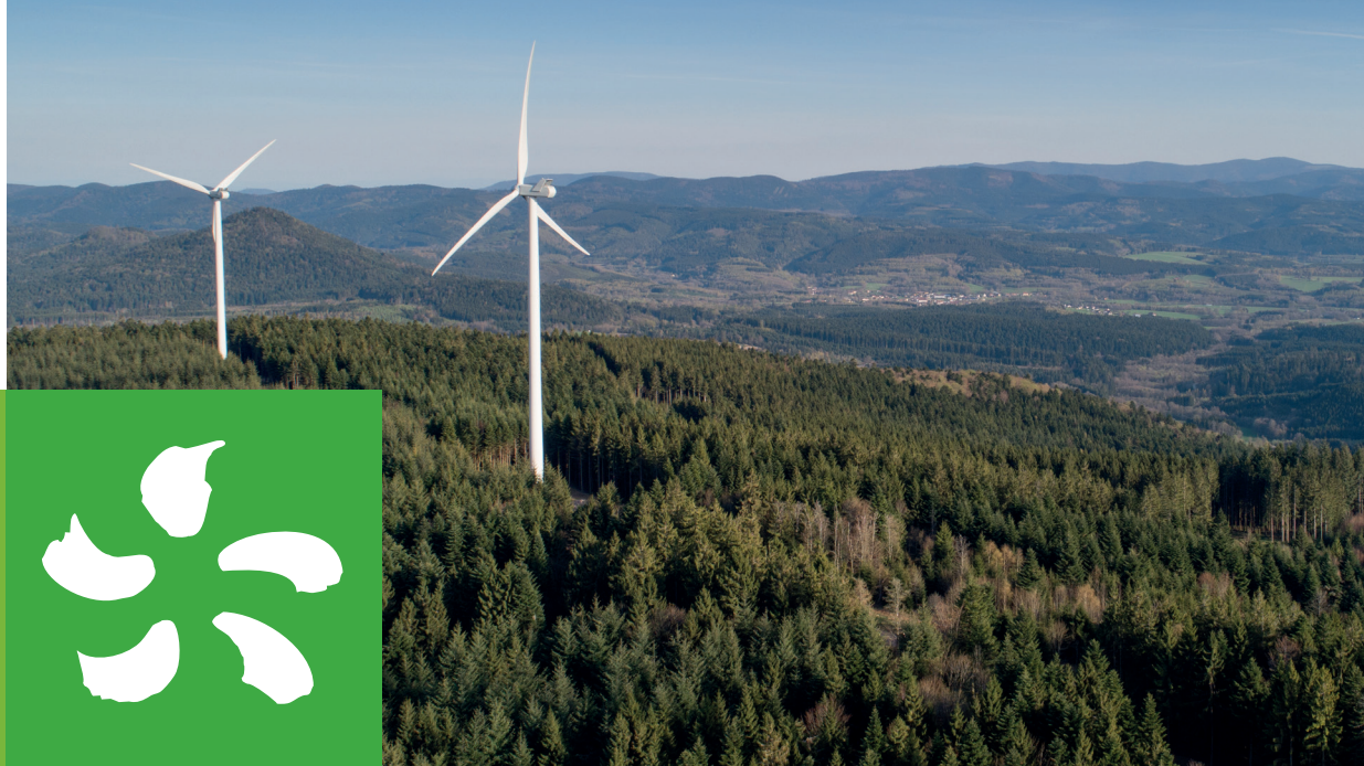
Parc éolien de Belfays (Grand-Est) - 20 MW
