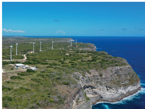
Parc éolien de Petit Canal (Outre-Mer) – 9 MW : le parc de Petit Canal a fait l'objet d'un repowering en 2020 : le nombre d'éoliennes a été réduit de 32 à 10 pour un gain de puissance de 7 à 9 MW.
