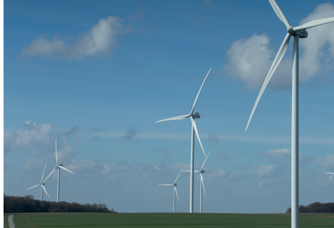
Parc éolien de Champagne-Picarde (Hauts-de-France) – 73 MW : composé de 22 éoliennes Vestas de 3,3 MW de puissance unitaire, il est l'un des plus grands parcs éoliens terrestres exploités par EDF power solutions en France.
